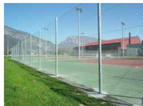
La clôture des courts de tennis a été entièrement refaite
